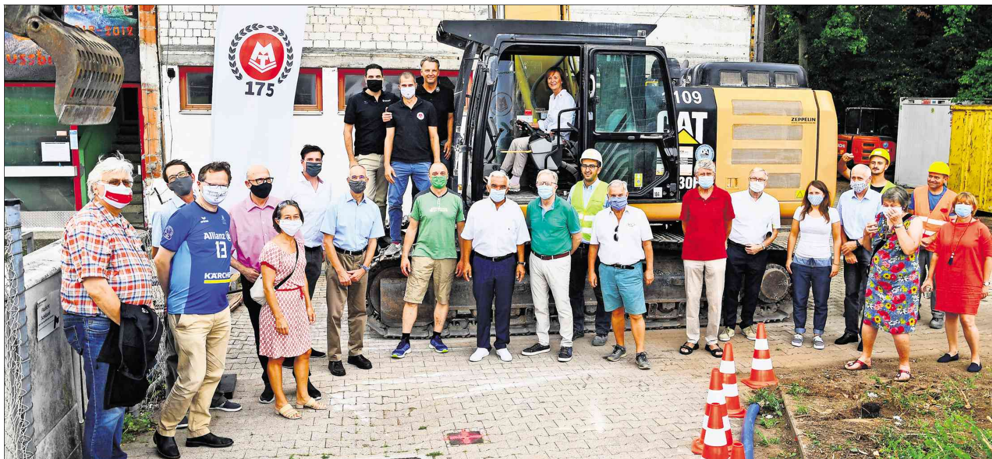
Start für den Bau des Multifunktionsbaus Sportpunkt, auf dem MTV-Gelände. Zunächst muss das 60 Jahre alte Gebäude abgerissen werden. ,
