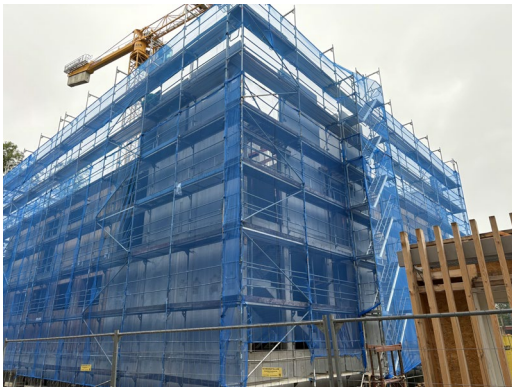
Bildunterschrift: Der Rohbau des Neubaus „Sportpunkt“ beim MTV Stuttgart wächst. Foto: Nusser Systembau GmbH
